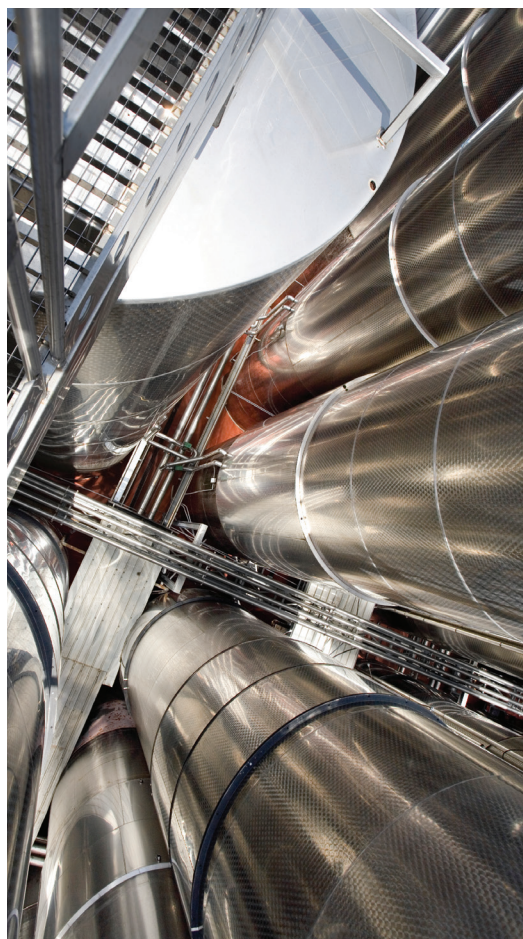
Silos, serbatoio e tramoggia
